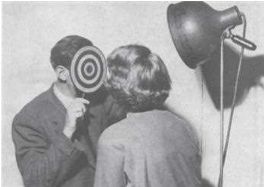
• FIG. 8.16 Placido keratoscopic disc.
